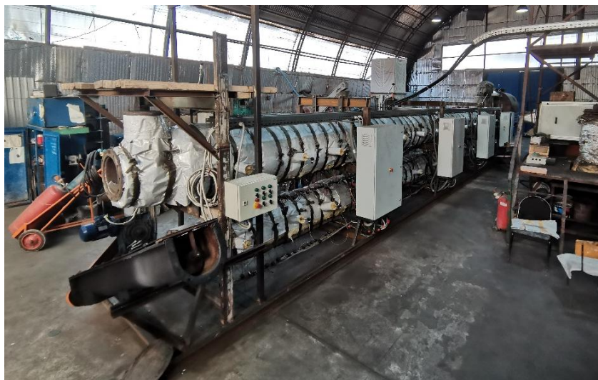
Рисунок 5.5 Общий вид опытно-промышленной установки низкотемпературного термолиза на производственной площадке ООО «ТК «Экотранс» в стадии сборки и монтажа оборудования
